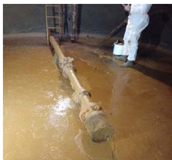
Intérieur d'une cuve
