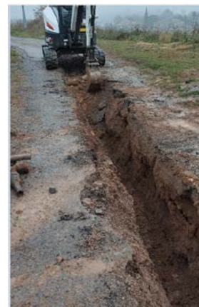
Changement de canalisation chemin de Denize
