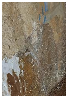
Extérieur d'une cuve
