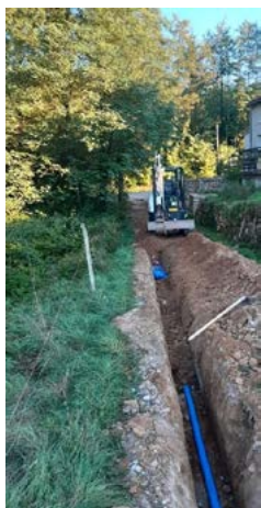
Changement de canalisation Lieu-dit « La Bour-nache »
