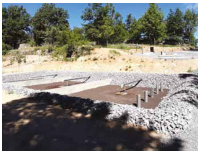
Station d'épuration en attente des roseaux.
