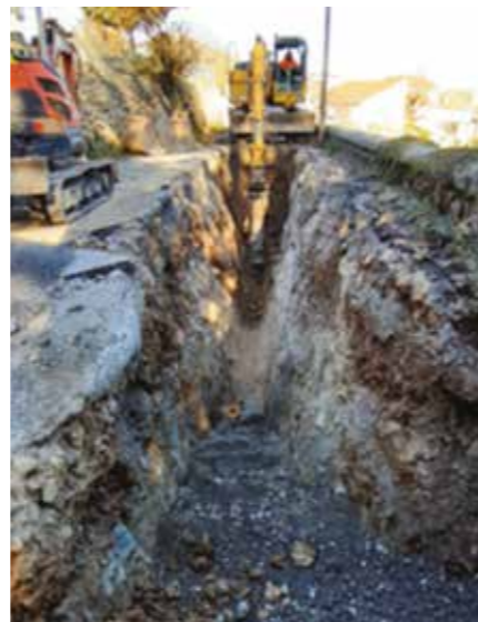
Pose de collecteur d'assainissement.
