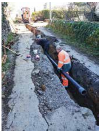
Changement de canalisation, chemin de la Rode.
