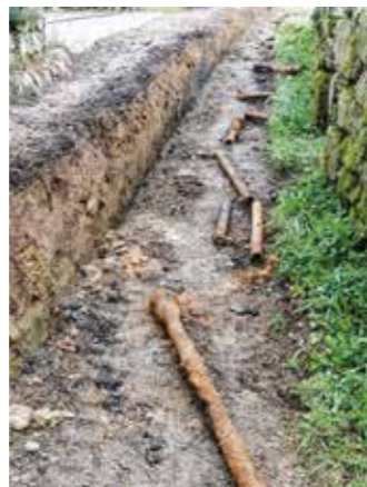
Changement de canalisation, chemin de Soubize.
