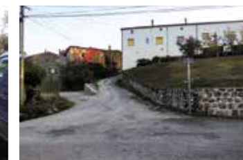
Chemin de Montredon (y compris réfection muret).
