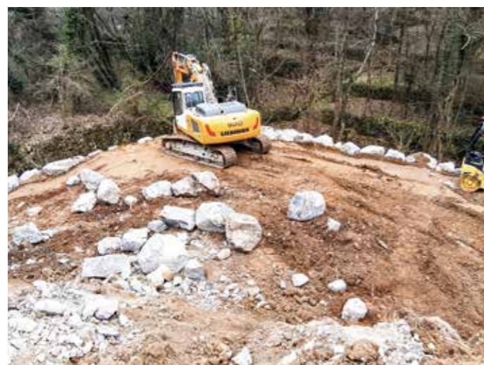
Création de la plateforme.
